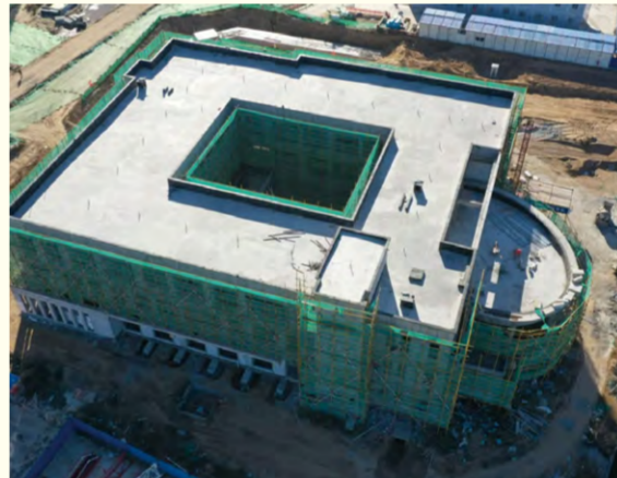
建设中的行政楼
